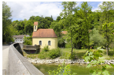
St. Nikolauskapelle an der Amper
