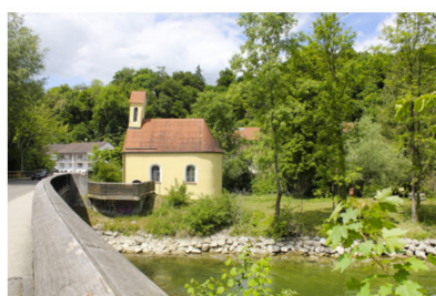
St. Nikolauskapelle an der Amper
